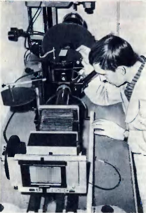
В металлографической лаборатории НИИ мы видели сложнейший металлографический микроскоп для исследования микроструктуры металла, то есть его внутреннего строения.
